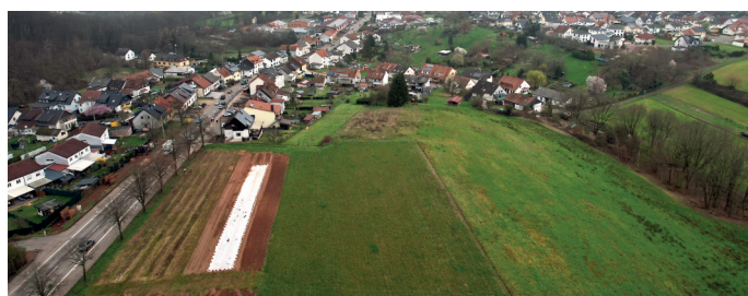
Erschließung Neubaugebiet Ölgrund in 2 Bauabschnitten
