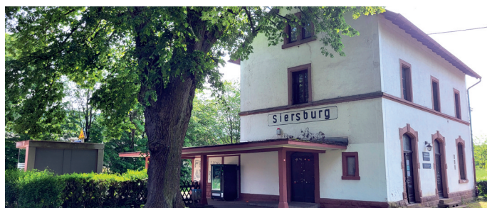
Sanierung Bahnhof: 600.000 Euro, Zuschuss: 450.000 Euro
