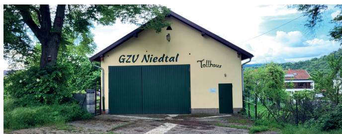
Tollhaus: Sanierung und Ersatz des Dachstuhls und Sanierung des Mauerwerks: 200.000 Euro, Zuschuss: 160.000 Euro
