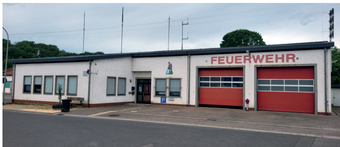
Dachsanierung Feuerwehrgerätehaus: 200.000 Euro
