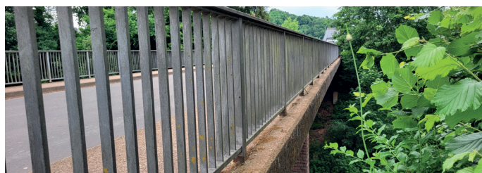
Sanierung der Brücke über die Eisenbahn (Itzbachtalstraße): Überbau, Geländer und Belag 240.000 Euro in 2027
