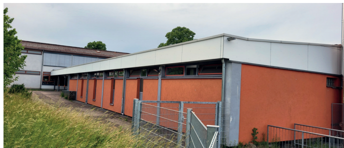
Umbau Werkstattgebäude an der Grundschule über das Schulbauförderprogramm des Landes: 500.000 Euro, Zuschuss: 377.000 Euro
