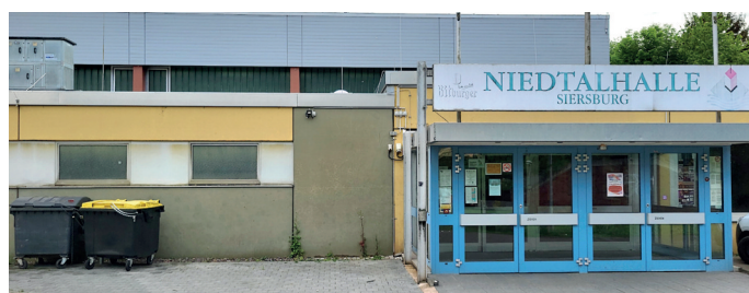
Niedtalhalle: Elektroverkabelung, Duschen, Wasserleitungen, Boden: 2027-2029: Investition: 2 Millionen Euro, Zuschuss: 750.000 Euro
