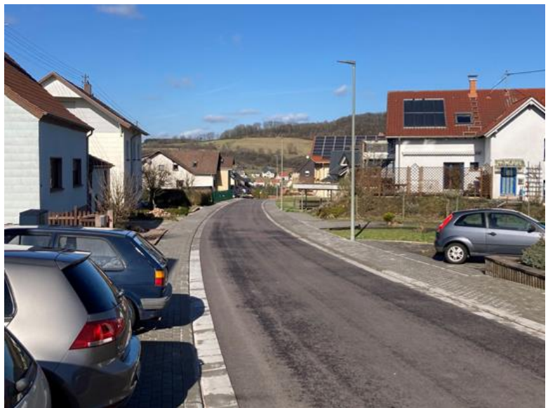
Die fertig sanierte Simmelbergstraße in Limbach
